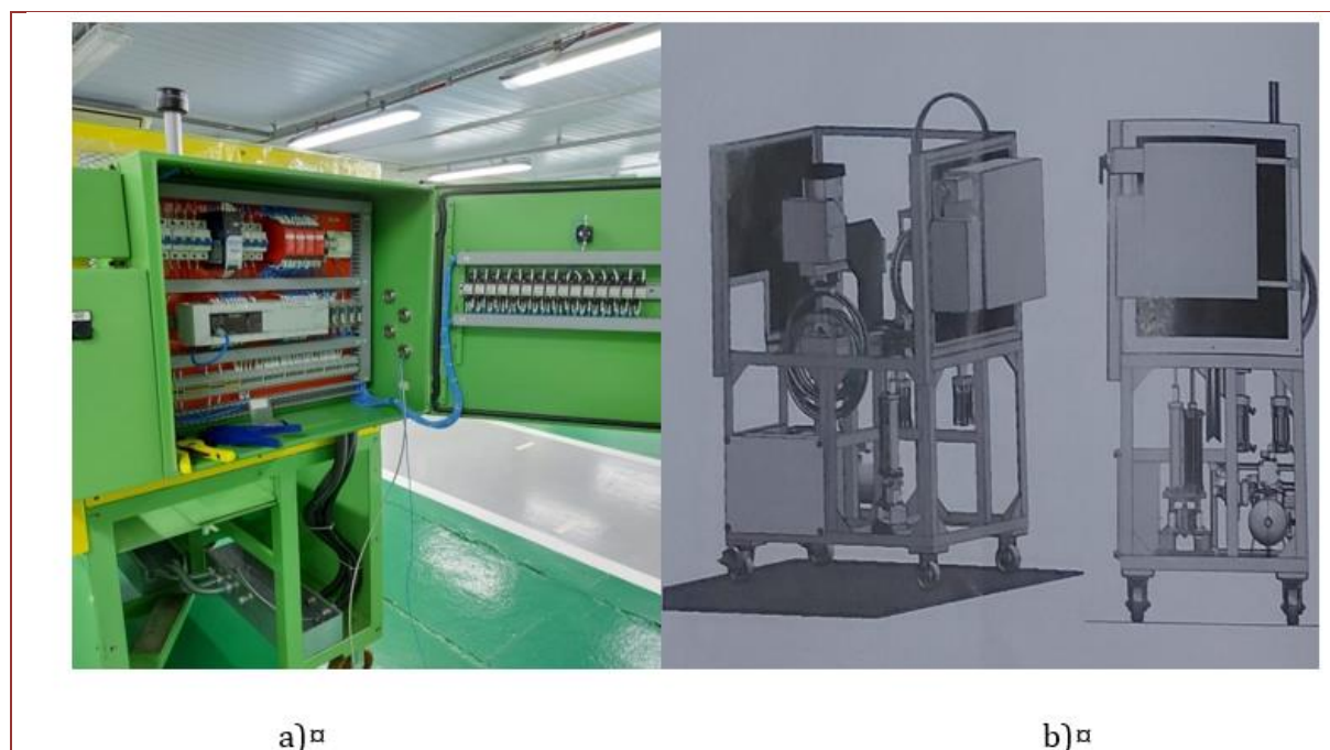
Figura 2: a) mostra a montagem do quadro elétrico, b) mostra a ilustração do equipamento finalizado.
