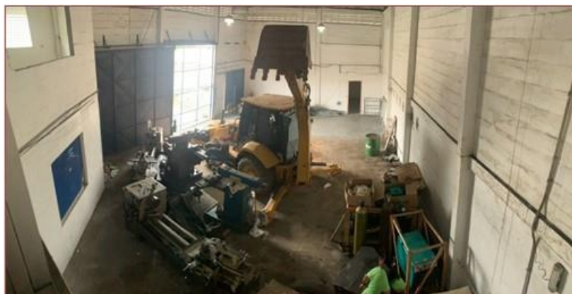
Figura 1: Galpão antes da adequação com NBR 5410
