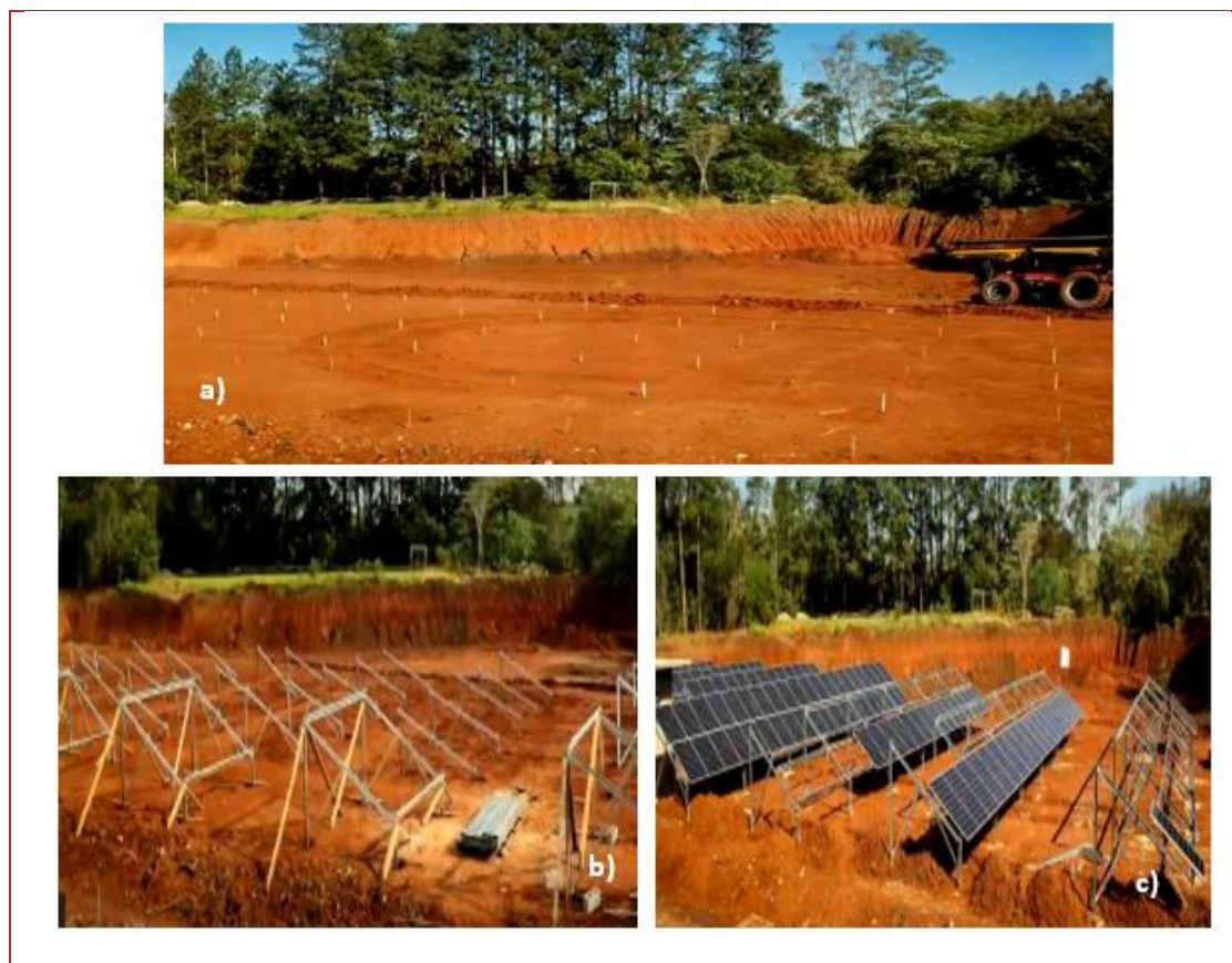
Figura 5: a) Preparação e nivelamento do solo; b) colocação das estruturas de fixação das placas; c) fixação das placas aos módulos.
