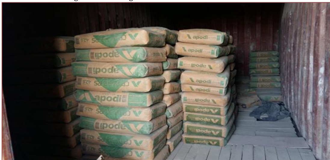
Figura 44 - Estocagem do cimento no interior do contêiner
