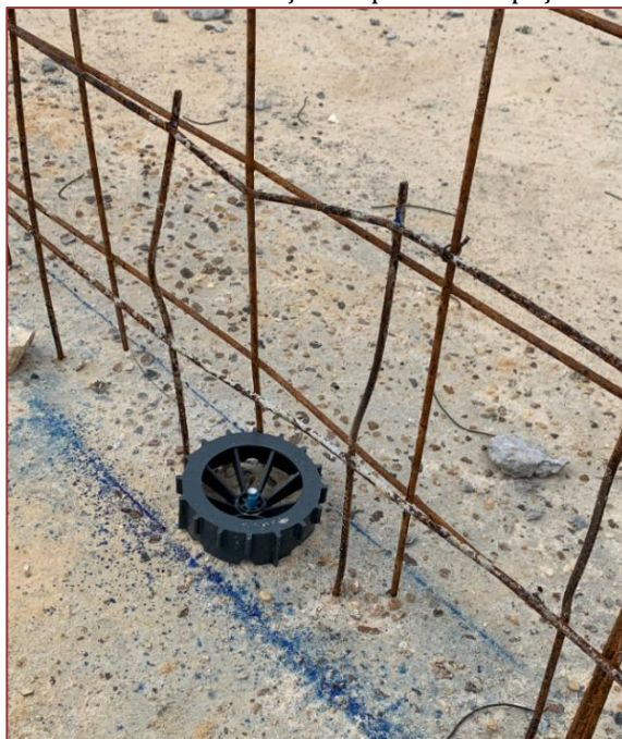
Figura 3 - Linhas de marcação de parede e espaçador GAP
