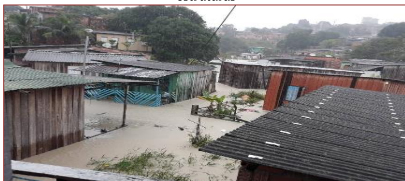
Figura 2 - Rua Bela Vista, na comunidade Nova Vitória, ocupações irregulares e desprovidas de infra-estruturas
