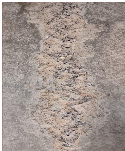
Figura 7 - Segregação do concreto
