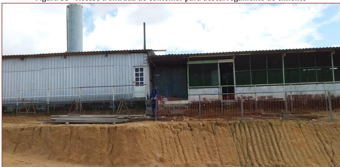
Figura 55 - Acesso à entrada do contêiner para descarregamento do cimento
