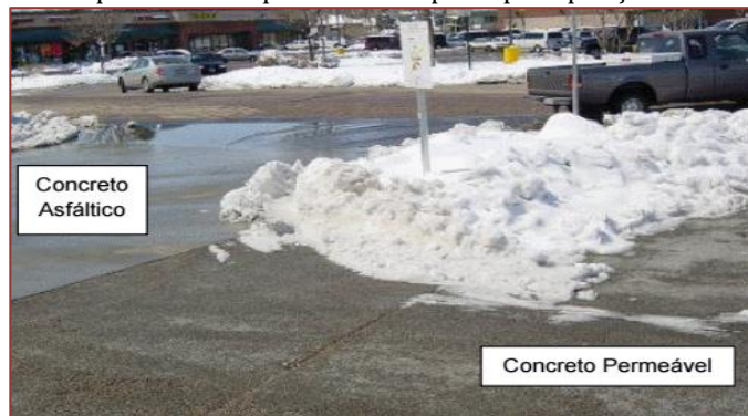
Figura 1 - Diferença das superfícies dos pavimentos após a precipitação no estacionamento de Iowa
