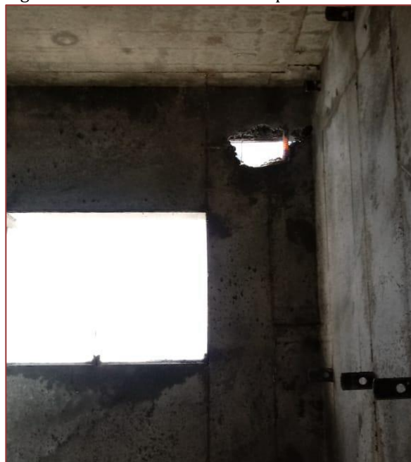
Figura 69 - Bicheira identificada após desforma
