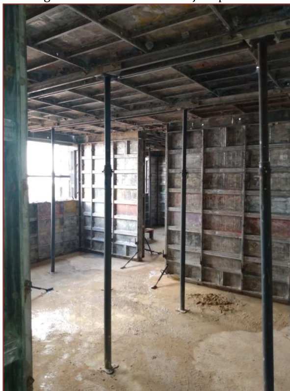
Figura 4 - Escoramento da laje superior
