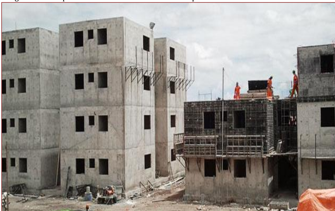
Figura 1 - Exemplo de obra construída no sistema de paredes de concreto moldadas no local
