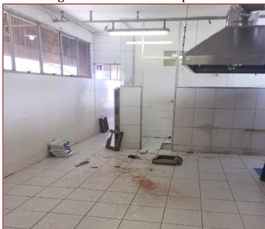
Figura 4: Piso cerâmico prensado
