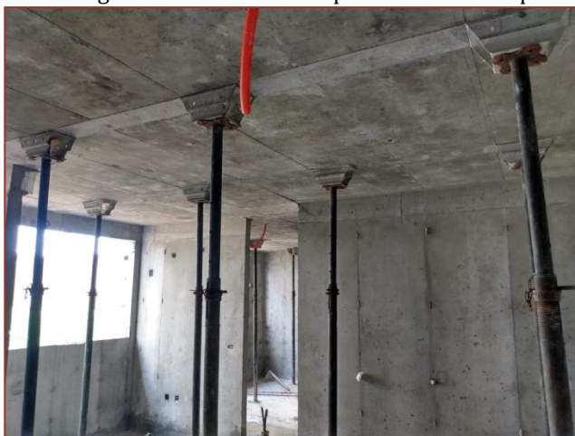
Figura 5 - escoramento após desforma dos painéis
