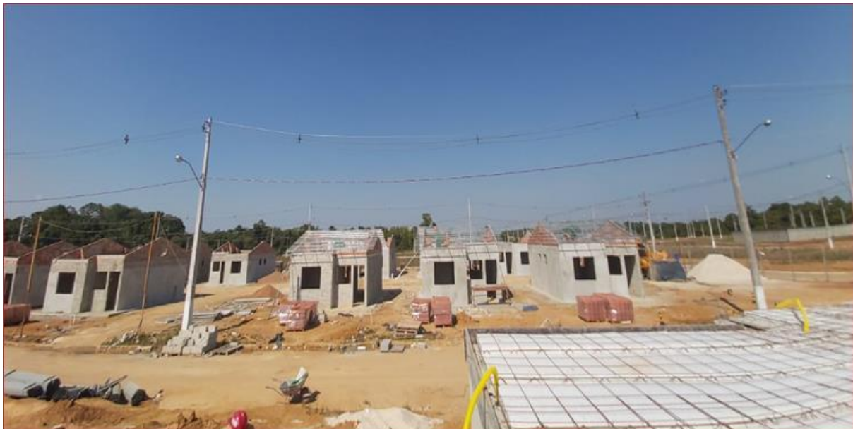
Figura 9 – Obras em execução durante a pandemia,
