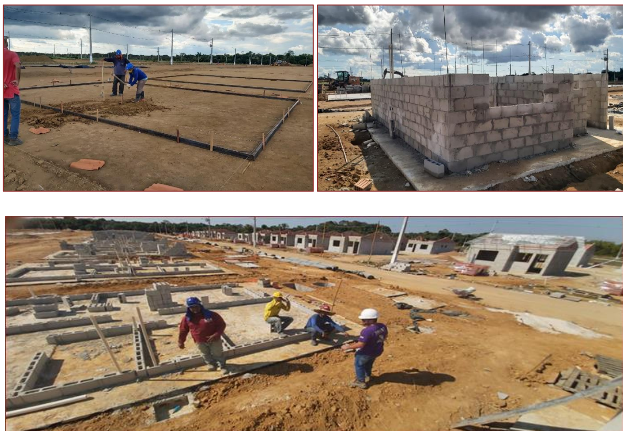
Figura 3 – Etapas da construção.
