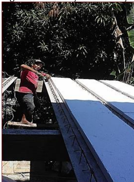
Figura 2 – Colocação das treliças
