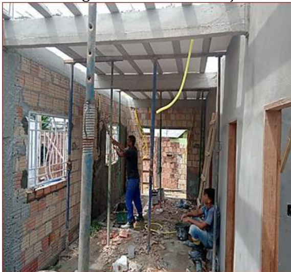
Figura 5 – Escoras de aço
