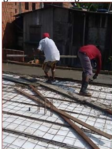
Figura 4 – Concretagem
