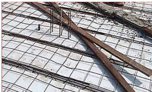
Figura 3 – Material de enchimento e armadura
