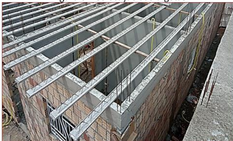
Figura 6 – Colocação das Vigotas
