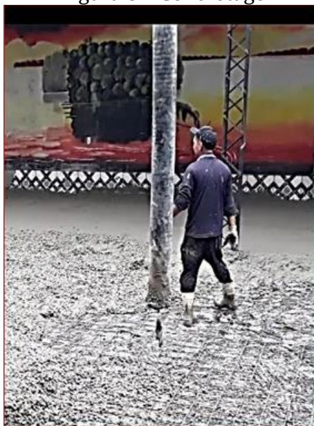
Figura 8 – Concretagem
