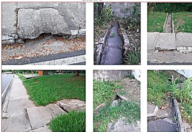
Figura 4 – Bocas de lobo situadas nas ruas Professor Samuel Benchimol e Wilson de Castro
