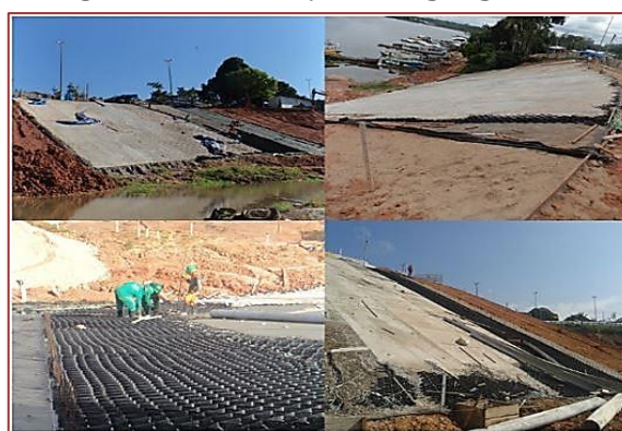
Figura 2 – Instalação das geogrelhas
