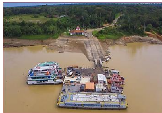
Figura 7 – Vista Frontal Porto do Gavião/Carauari
