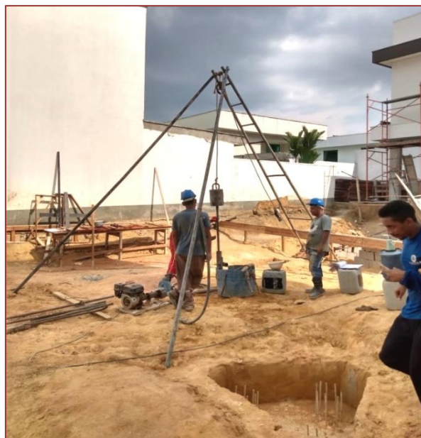
Figura 1 - Sondagem SPT no lote 251
