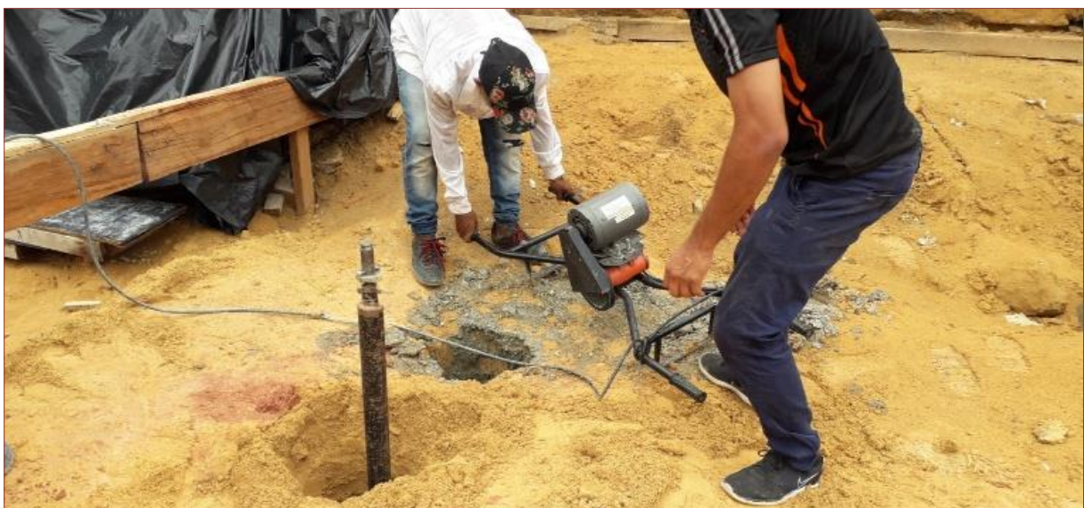
Figura 4 - Perfuração com Trado Mecânico
