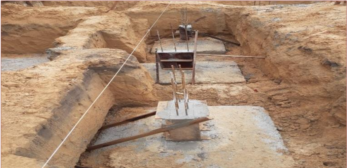
Figura 7 - Execução da Sapata Isolada
