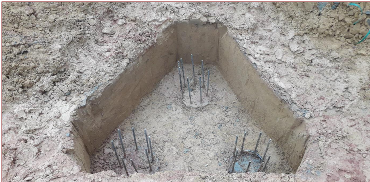
Figura 5 - Fundação Estaca Broca
