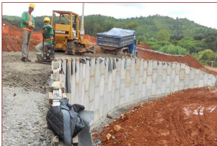
Figura 08- Reaterro Contenção
