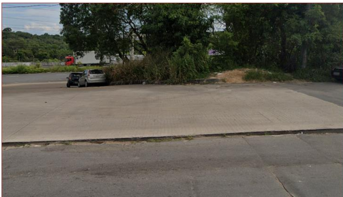
Figura 9 – Desnível pavimento – acostamento
