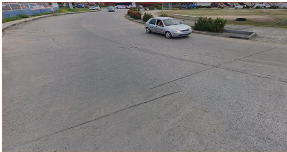
Figura 8 – Fissuras lineares
