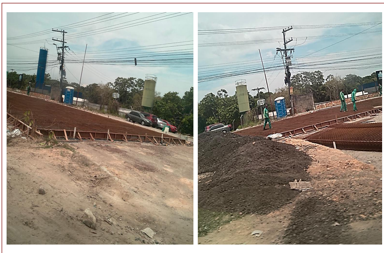
Figura 6 – Implantação de pavimento rígido no Distrito Industrial de Manaus.
