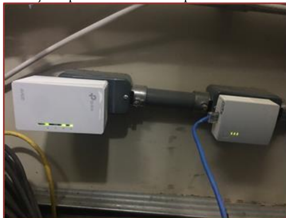
Figura 6 - Instalação e pareamento dos adaptadores PLC na rede elétrica.
