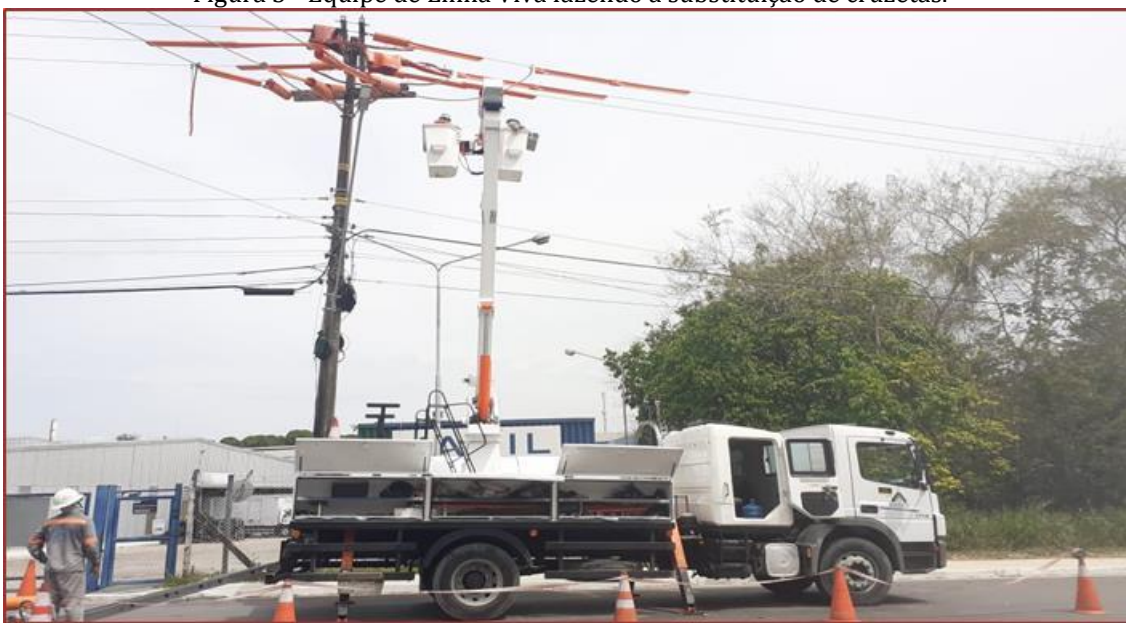
Figura 3 - Equipe de Linha Viva fazendo a substituição de cruzetas.
