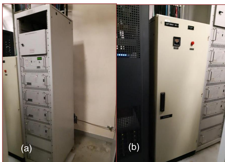
Figura 5. Inversor remanejado para nova SR 02, em (a) entrada da SR antiga e em (b) instalado na SR2
