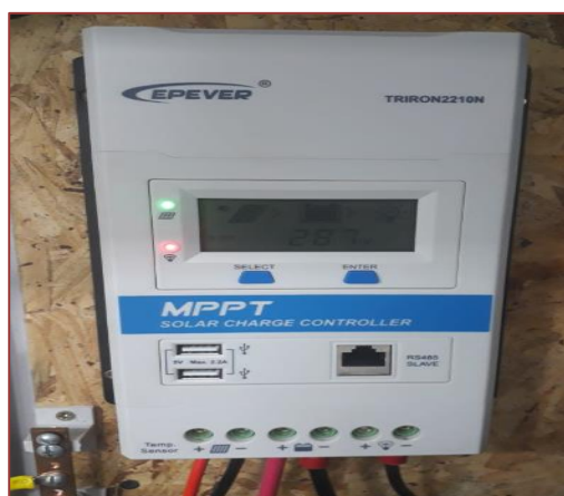
Figura 5: Controlador de carga, foto no local do projeto piloto
