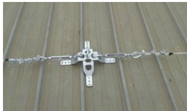
Figura 6. Dispositivo de ancoragem Tipo C.
