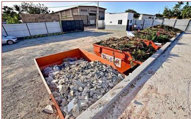
Figura 3 – Descarte correto de resíduos sólidos da Construção Civil
