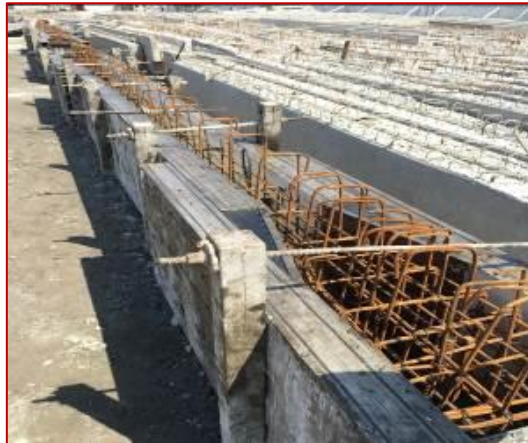
Figura 4. Central de armação do canteiro
