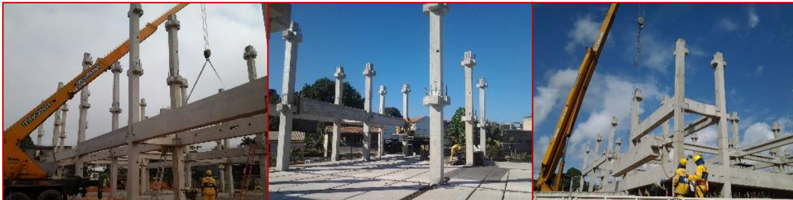
Figura 9. Içamento e ligação das vigas com os pilares
