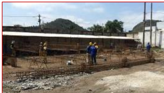
Figura 2. Central de armação do canteiro
