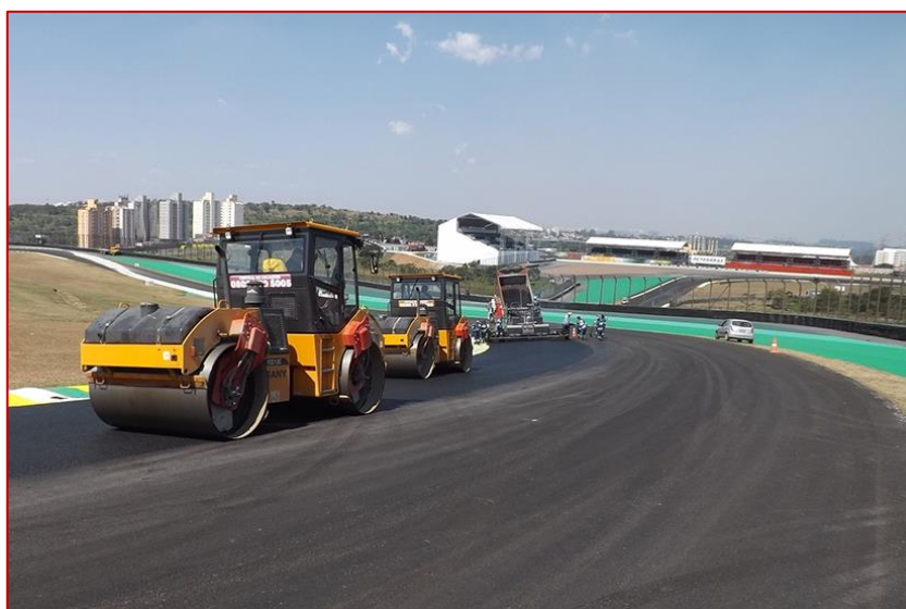
Figura 3 - Recuperação do pavimento asfáltico da pista principal do Autódromo José Carlos Pace, realizado no ano de 2014.
