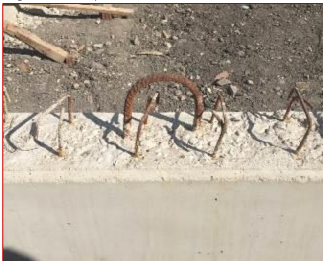
Figura 11. Alça de levantamento em desacordo
