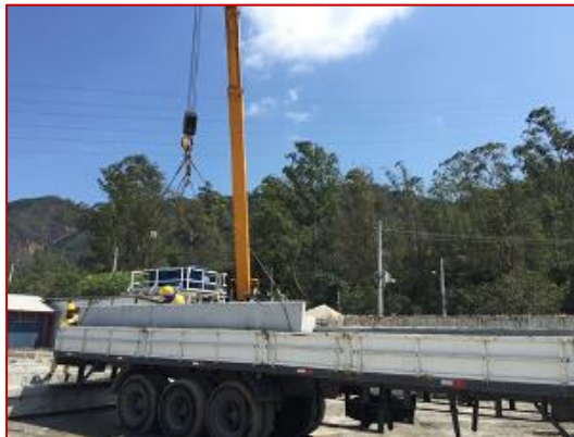
Figura 5. Carregamento do caminhão com elementos pré-moldados
