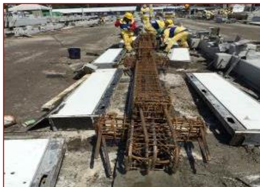
Figura 3. Montagem do molde para produção de pilar-pré-moldado
