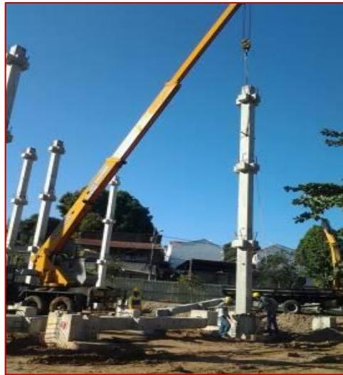
Figura 6. Posicionamento do pilar no cálice
