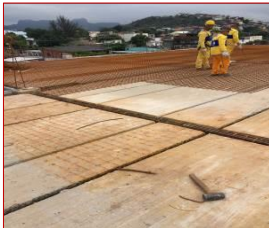
Figura 10. Lajes parcialmente pré-moldadas sendo armadas
