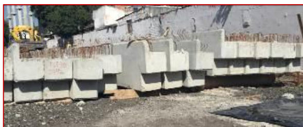
Figura 12. Armazenamento sobre madeira e cilindro de concreto
