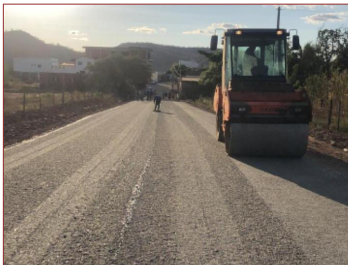
Figura 6. Compactação com rolo vibratório liso
