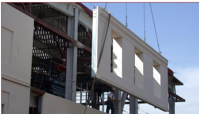
Figura 1. Utilização e instalação de estrutura pré-moldada
