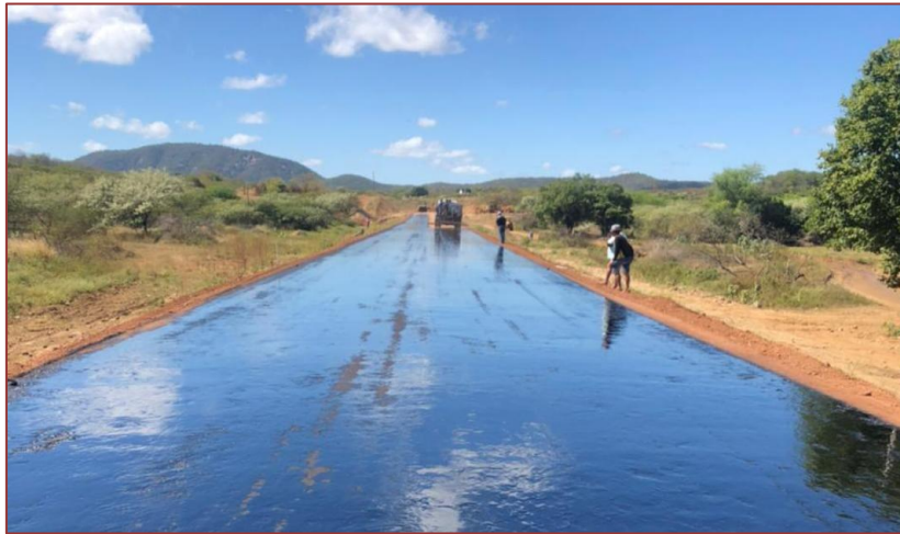
Figura 3. Aplicação do CM-30 na via
