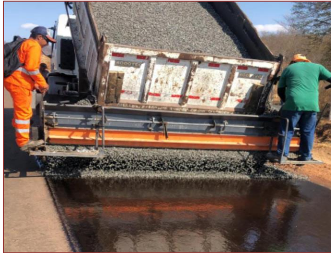
Figura 5. Distribuição da brita 1 sobre o RR-2C
