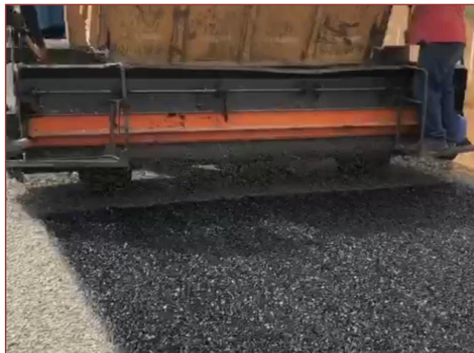
Figura 7. Execução da segunda camada
