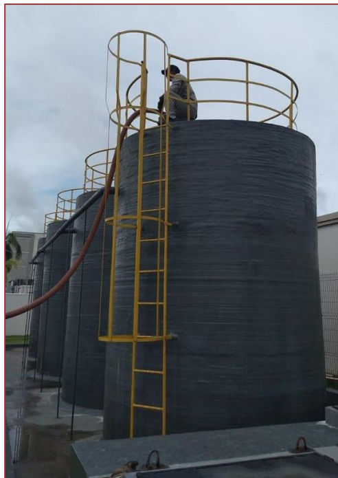
Figura 3. Despejo dos resíduos nos tanques da Estação de Tratamento de Esgoto Aeróbio.
