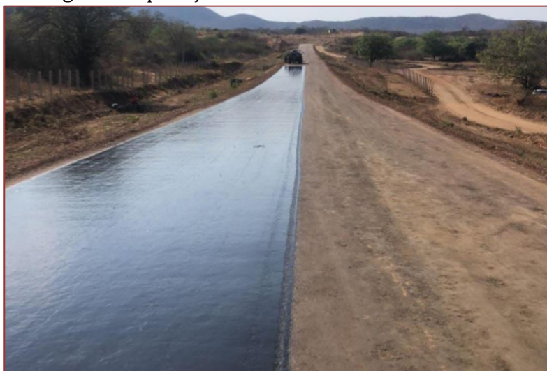
Figura 4. Aplicação da Emulsão Asfáltica RR-2C
