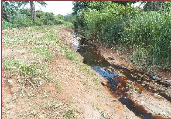
Figura 6 - Vazamento de Chorume em Aterro no Rio de Janeiro
