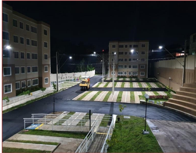
Figura 1. Pavimento com revestimento asfáltico
