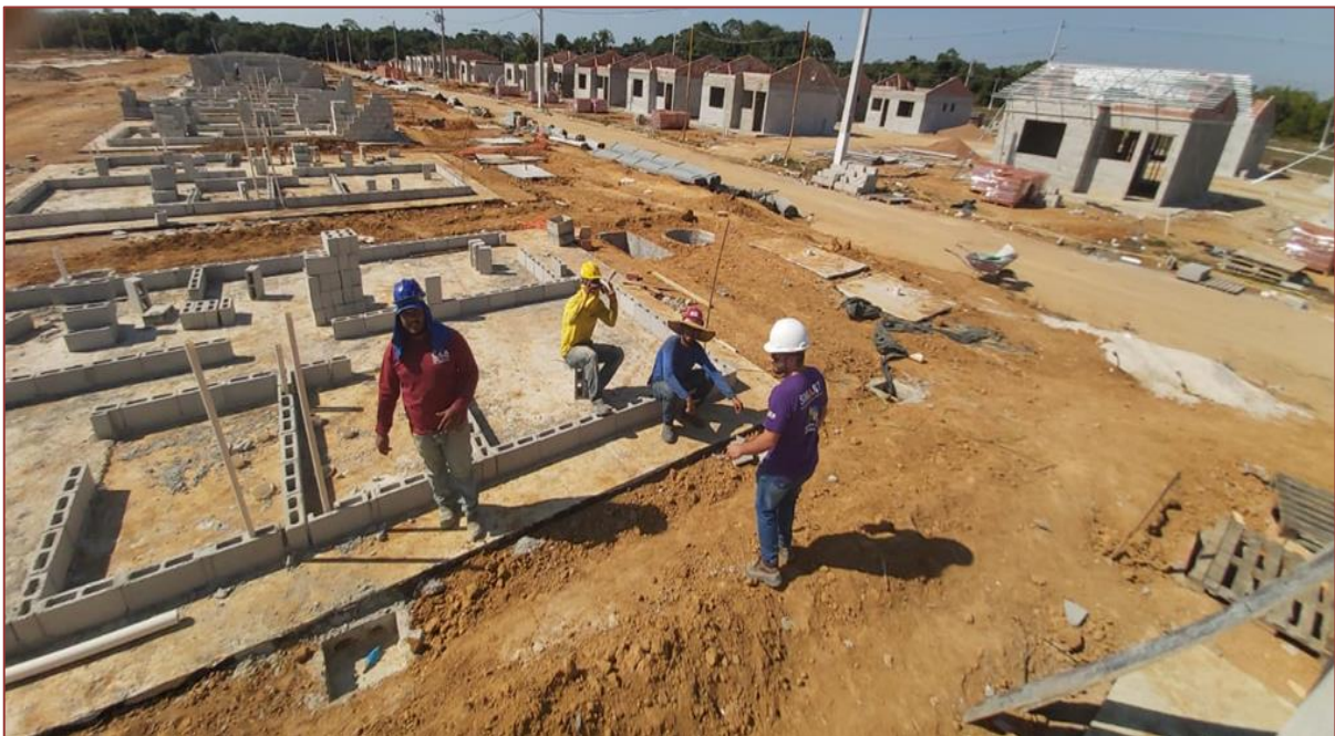
Figura 4 – Execução de atividade no canteiro de obra
