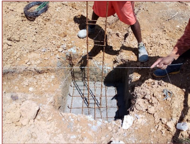
Figura 9: Colocação da armação dos pilares antes da concretagem
