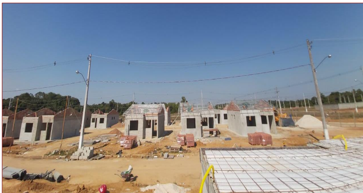
Figura 2 – Canteiro de Obra escolhido para o estudo
