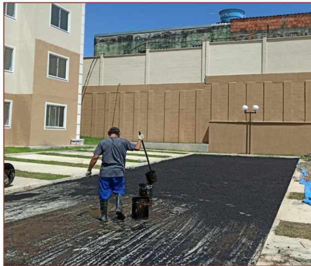
Figura 4. Aplicação manual do ligante CM-30
