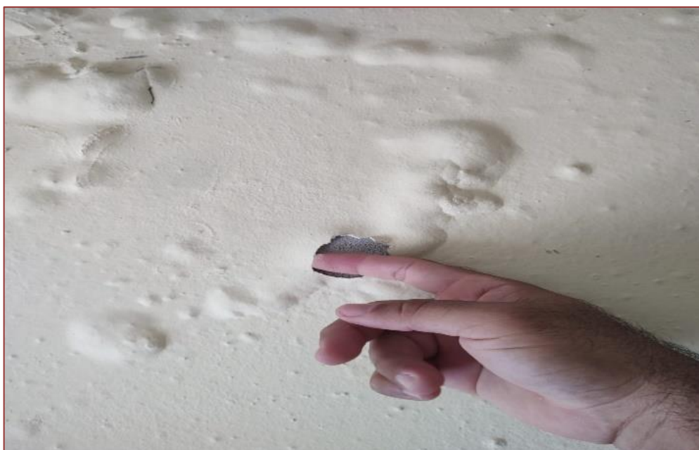
Figura 6. Rodapé da Sala com saponificação
