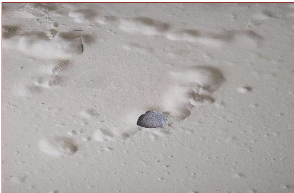
Figura 5. Rodapé da Sala com saponificação
