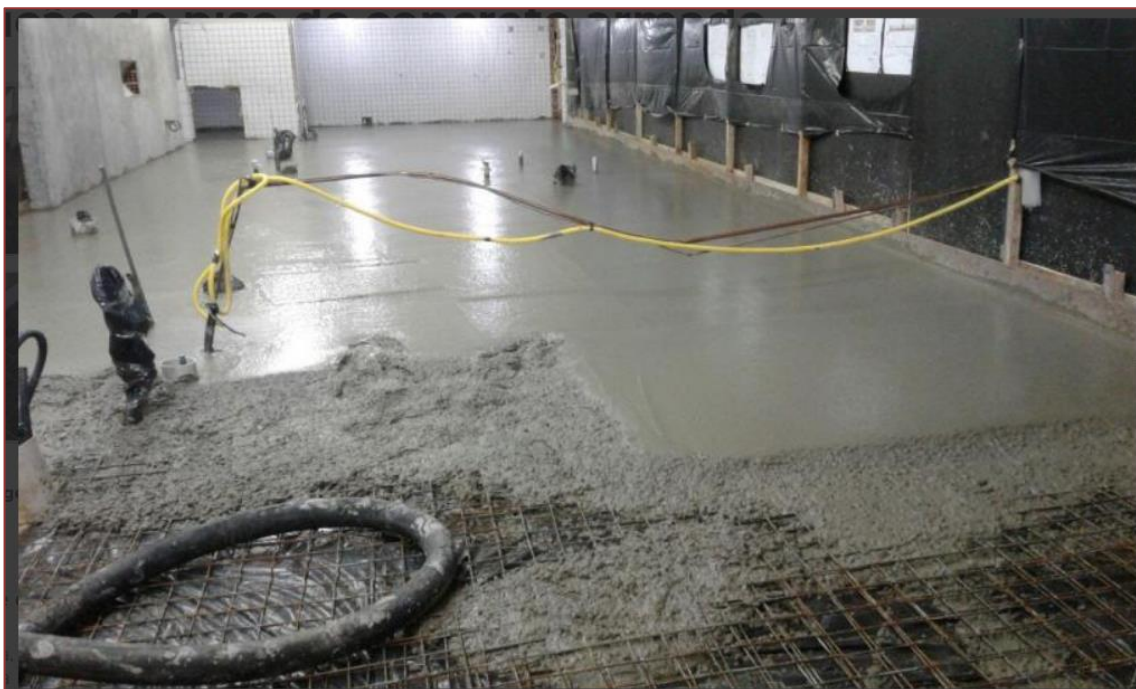
Figura 5 – Execução de piso de Concreto
