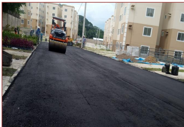
Figura 7. Compactação do CBUQ
