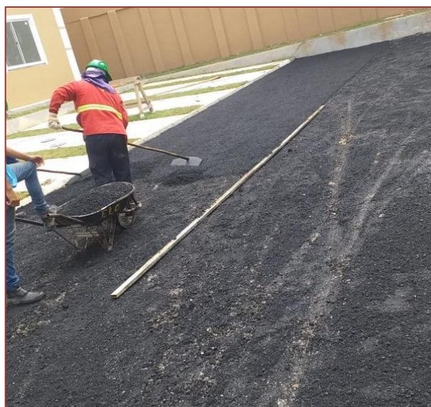
Figura 5. Execução manual da pintura de ligação
