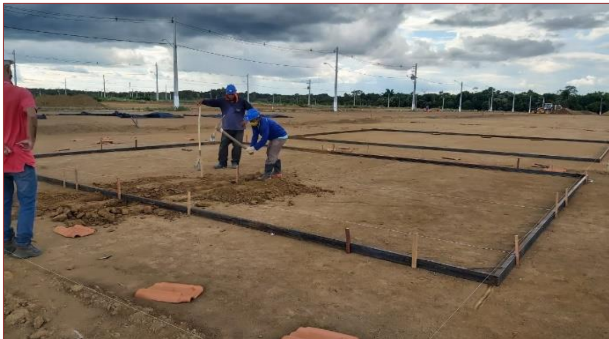
Figura 3 – Processo inicial de construção de residência
