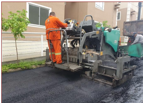
Figura 6. Distribuição do CBUQ com o auxílio de uma pavimentadora
