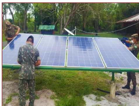
Figura 3. Instalação de Painéis Fotovoltaicos do 5º PEF/Maturacá-AM
